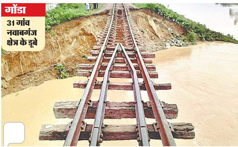
बहराइच के मिर्हीपुरवा में ट्रैक के नीचे की मिट्टी खिसकने से गोंडा-मैलानी रेलखंड पर ट्रेनों का संचालन ठप।
