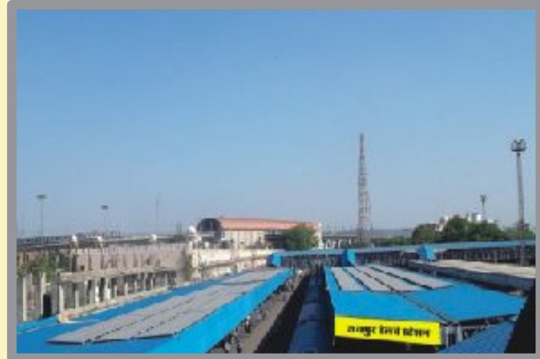
जयपुर रेलवे स्टेशन के प्लेटफार्म शेल्टर पर सोलर पैनल
