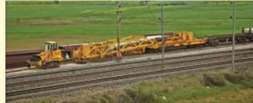
राजस्थान में डीएफसी-नये ट्रैक निर्माण के माध्यम से ट्रैक लिंकिंग
