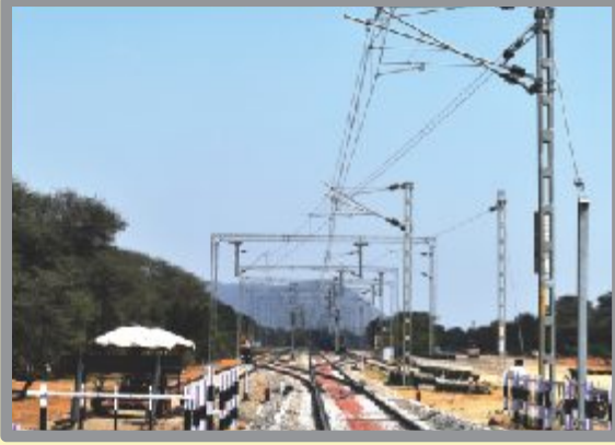
रींगस-फुलेरा खंड पर उच्च शिरोपरि उपस्कर
